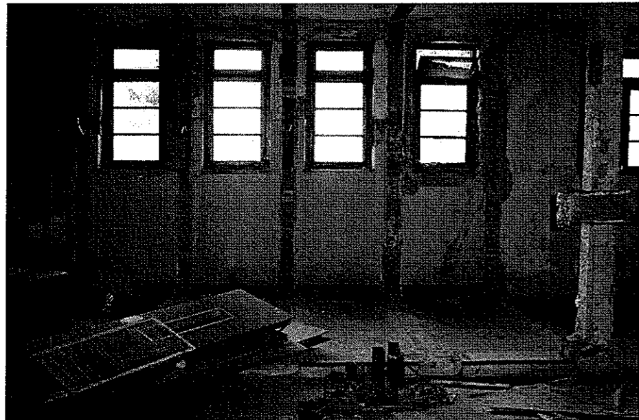
IMMOBILE IN VIA BORZOLI - MAGAZZINI AL PIANO SECONDO
